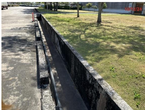
ภาพที่ 2-7 รางระบายน้ำฝนในโครงการ
